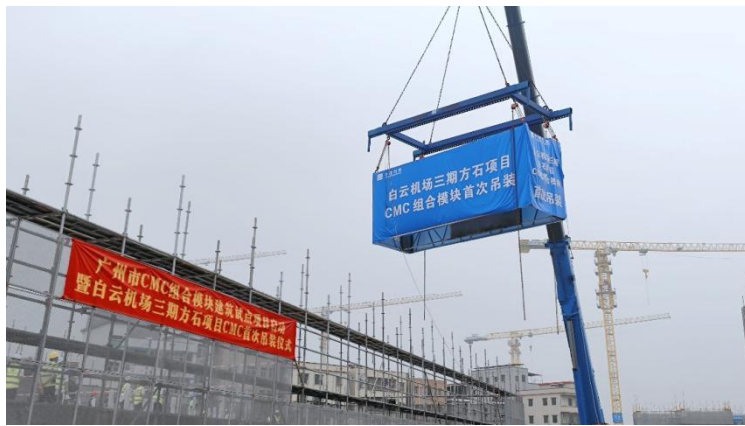
图 2 方石项目现场吊装图
